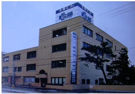
メディカルビル
