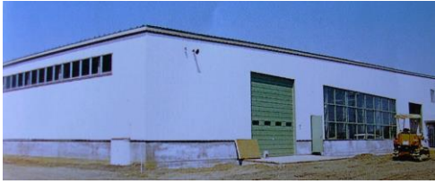
金属建具工場
