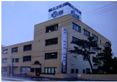
メディカルビル
