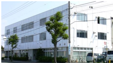
オフィスビル増築工事
